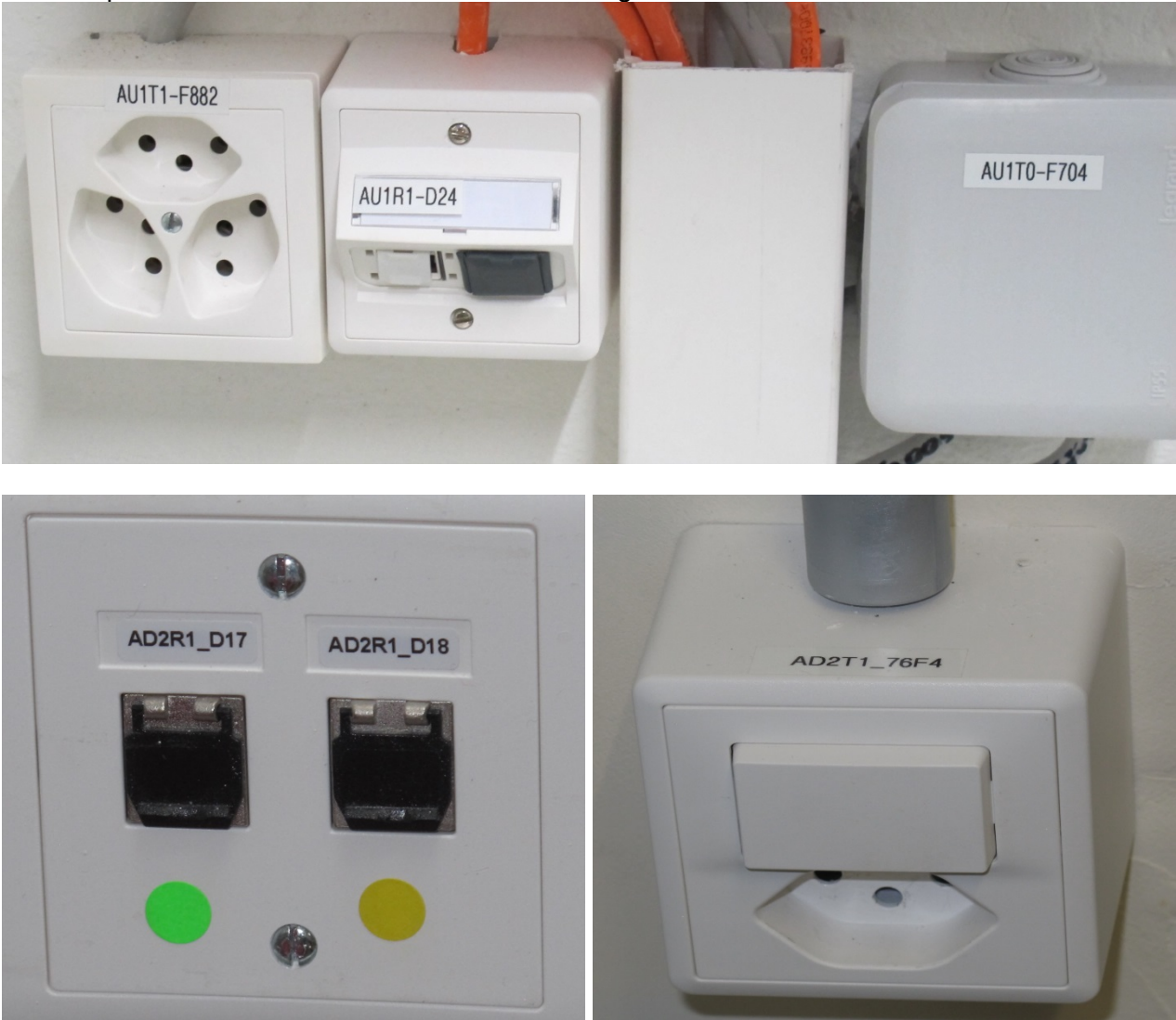
Fotobeispiele für Steckdosen, Schalter und Abzweigdose:
